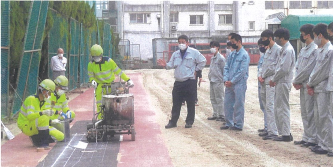
会員社による路面標示の実演施工
