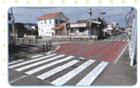
横断歩道は計4カ所を補修した
