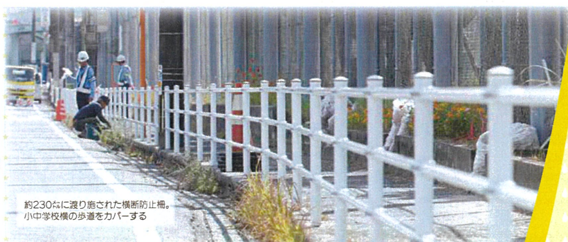
作業は2日間。初日に地中に埋めて支柱を固定。翌日にパイプをはめていった
