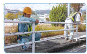
パイプをはめて仮止めした後、最後に一気にボルトを締めていく
