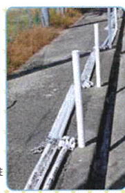
パイプをはめて仮止めした後、最後に一気にボルトを締めていく
