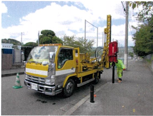
ガードパイプ施工状況
