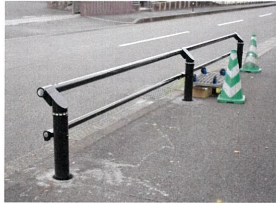
ガードパイプ (完成)
